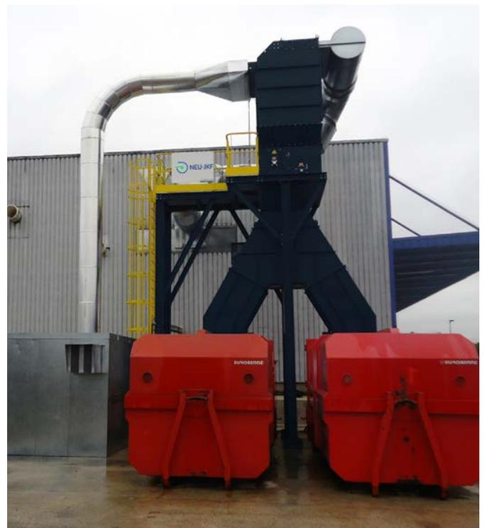
*Système de collecte pneumatique des déchets avec SEPAROJET M et CHOPPERLINE*
