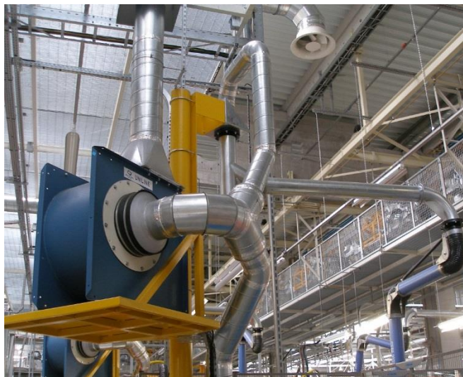
Extraction de fumées de soudure
