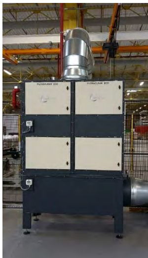
1 Filtre à poches dont le rôle est d'assurer la rétention d'un maximum de poussières (M6)
