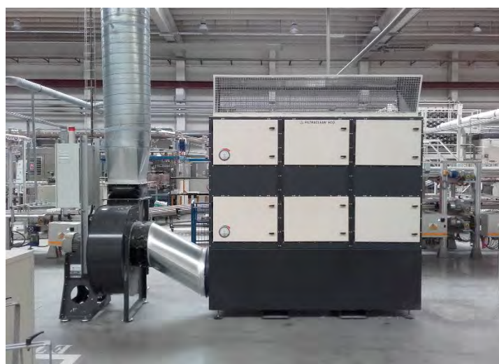
2 3 Second groupe de filtres (F8 et E11) haute efficacité
